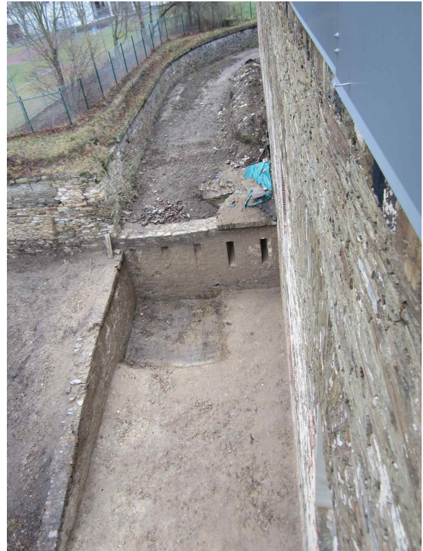
Trockener Graben nach bisher erfolgtem Aushub (Ansicht von Rheinseite)
