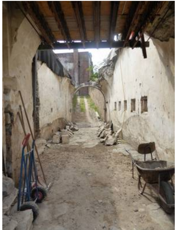
Sicht durch die freigelegte Poterne aus Richtung Kehlturn
