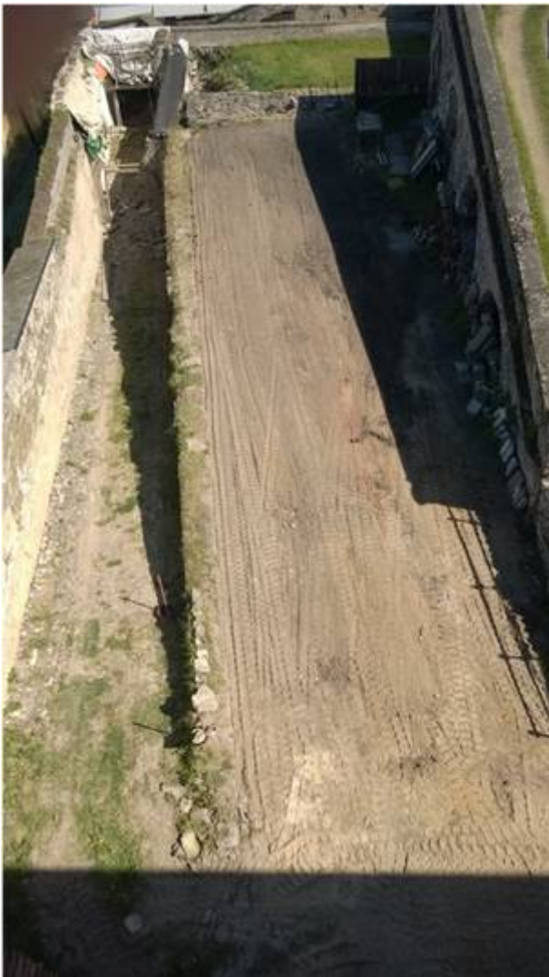
Mauerkrone der statisch gesicherten Rampenmauer
