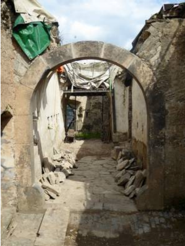
Die Gewände des Rundbogens sind nun statisch gesichert
