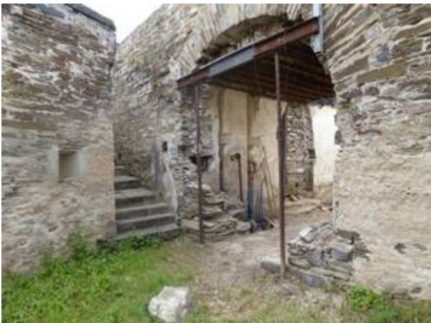
Ein Stützgerüst sichert Reste des Poternengewölbes
