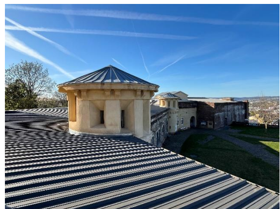
Im Zuge der Entfestigung sind auch die Erdbdeckungen auf den Kasematten entfernt worden.
