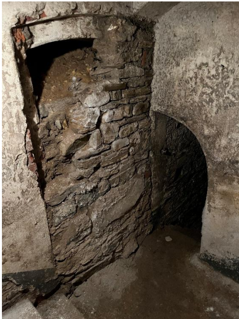
Im Bunkerbereich kann man noch die zugemauerte Tür zum früheren Pulvermagazin unterhalb des Innenhofs erkennen. Rechts davon ist der Eingang zum Belüftungsschacht, der als "Fenster" bis zum unteren Hof führt.
