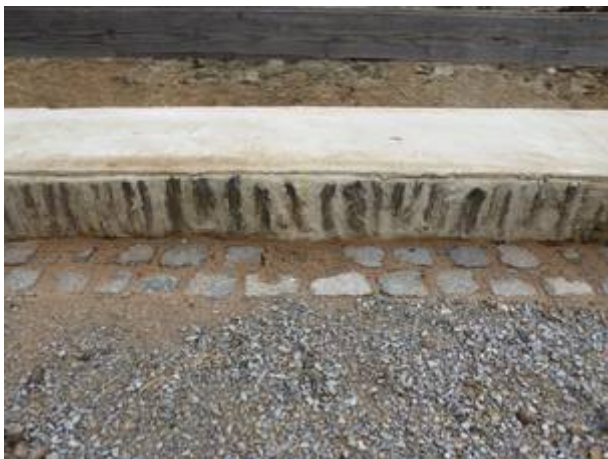
Pflasterung unterhalb der Mauerkrone
