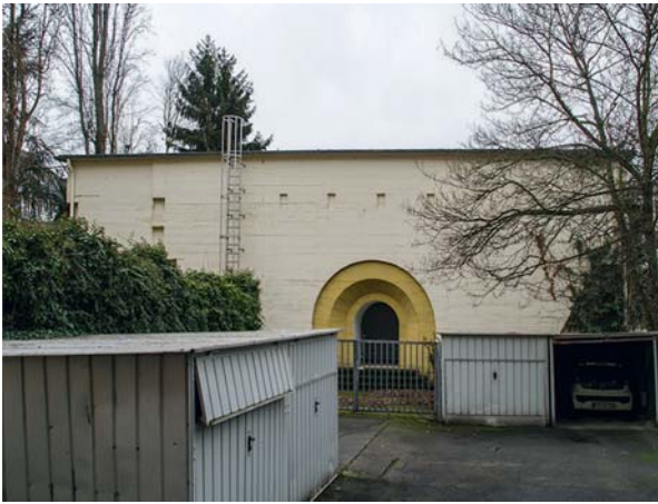
Kleiner Hochbunker im Innenhof eines Wohnblocks.
